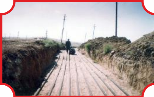
Mişovdağ quru neft yatağında yüksəktəzyiqli boruların montajı - 2003
