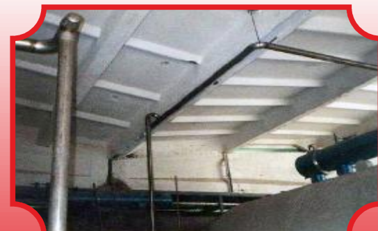
Bakı Pivə Zavodunun rekonstruksiyası - 1999
